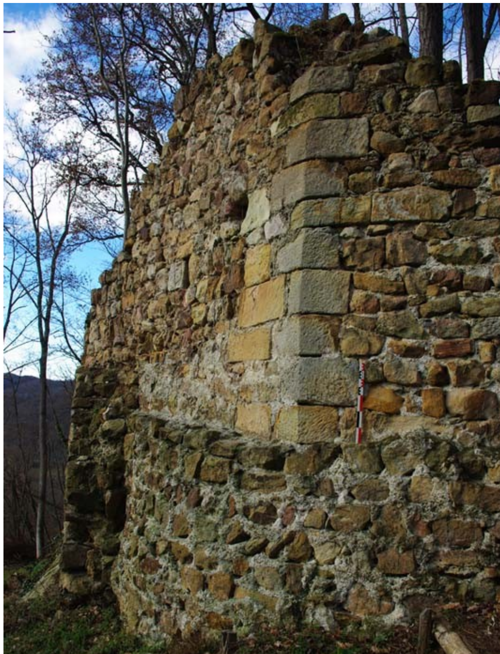
Chaîne des murs sud et est - Détail
