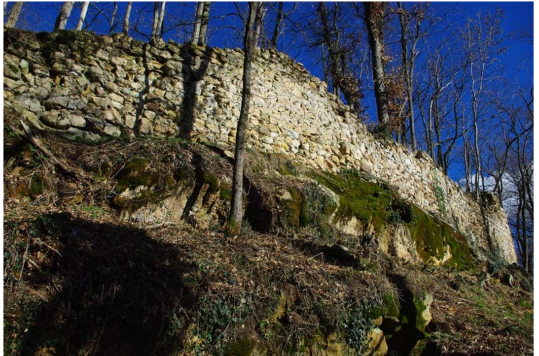
Le mur sud - Vue depuis l'ouest vers l'est
