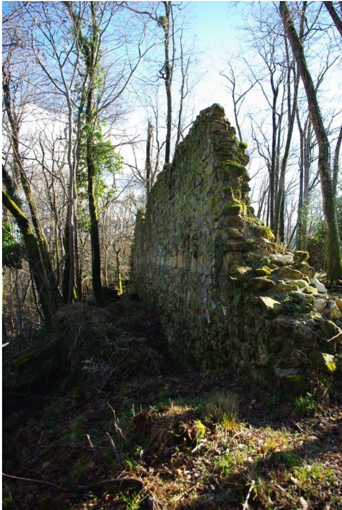
Le mur nord - Vue depuis le nord- ouest vers le sud-est
