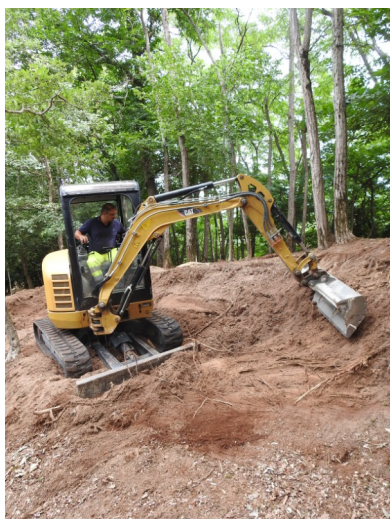
Figure 14: Décapage mécanique en cours, cliché L. Claeys
