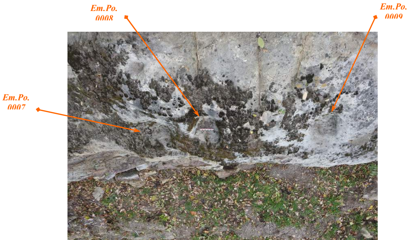
Em.Po. 0007 à 0009 - Vue depuis le contrehaut - Cliché Laurent Claeys - 07 novembre 2021
