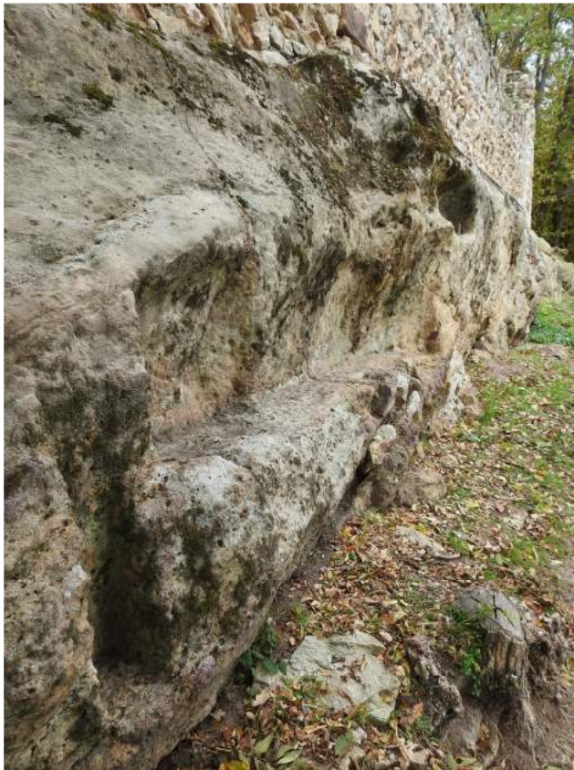
Renf.Tai. 0001 - Vue depuis le nord-ouest - Cliché Laurent Claëys - 07 novembre 2021
