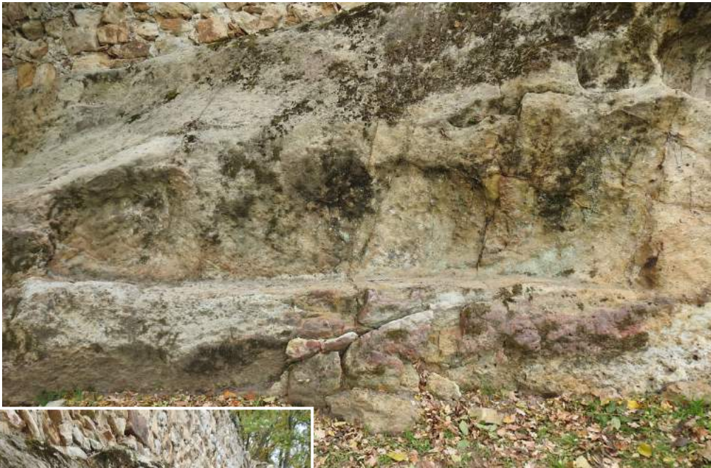
Renforcement taillé 0001 (Renf.Tai. 0001) - Vue depuis le sud-ouest - Cliché Laurent Claëys - 07 novembre 2021
