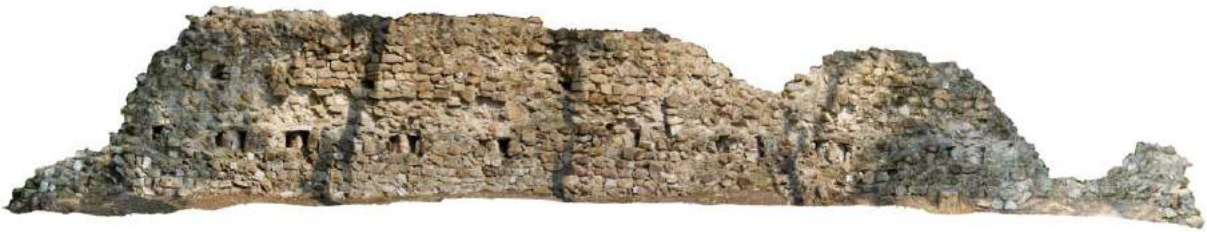
Mur Nord face sud (sans échelle)
