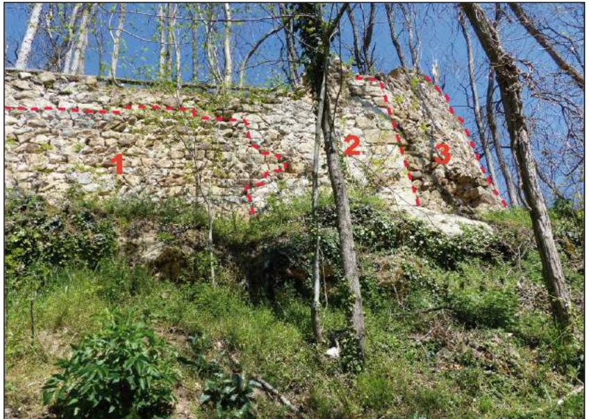
Fig. 4 - Front sud-ouest du château. 1 parement de moellons bruts assisés : 12e ou 13e siècle 2 : reprise de la courtine médiévale et chaîne d'angle 16/17e siècle. 3 : extension de l'enceinte primitive postérieure à la phase 2 : 16/17e siècle.
