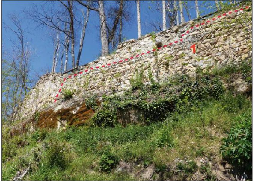
Fig. 3 - Front sud-ouest du château. 1 parement de moellons bruts assisés : 12e ou 13e siècle
