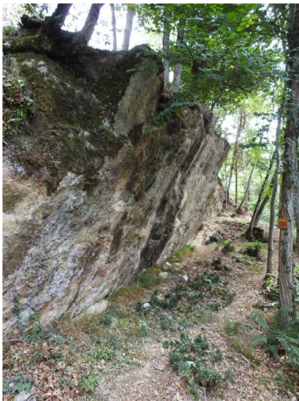
Dans le prolongement des affleurements rocheux vers le nord-ouest, la paroi rocheuse pour partie surplombante - Vue du nord-ouest vers le sud-est
