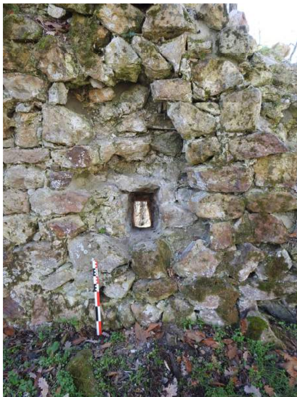
Élévation sud - La baie de tir dont l'encadrement n'a pas été conservé en face interne - Vue du nord vers le sud
