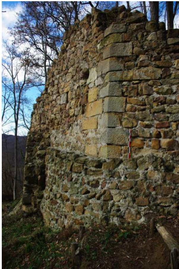
Elévation sud (partie) - Très nettement visible, une part du pied de l'élévation, que l'on pense entièrement reparamentée, sur laquelle est fondée la seconde chaîne formant angle, de part et d'autre de laquelle l'élévation sud a été rebâtie croit-on - Vue du sud vers le nord
