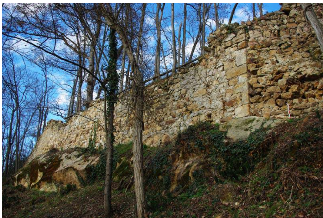
Le castella de Labarre - Une part du parement extérieur de l'élévation méridionale vue depuis le sud-est.
