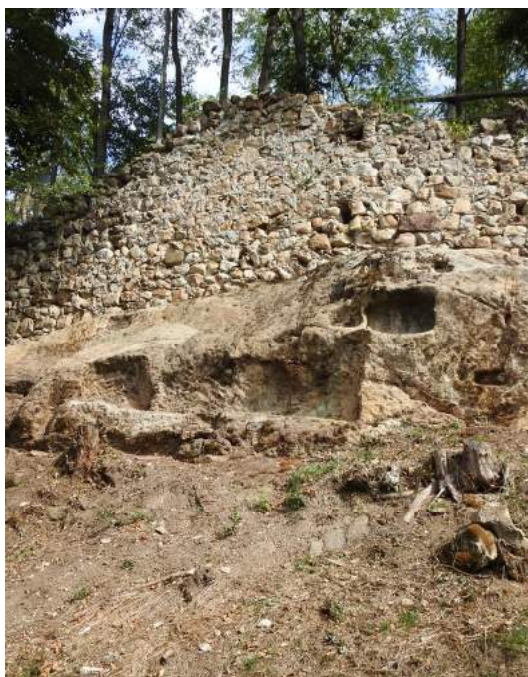
Les niches les plus imposantes ménagées dans l'affleurement rocheux au contrebas de la plate-forme sommitale - Vue du sud-ouest vers le nord-est
