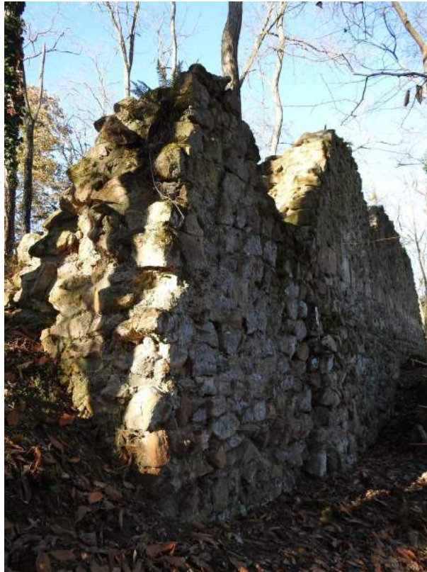
Extrémité sud-est de l'élévation - Face externe - On remarquera le mode de traitement du soubassement du restant de l'élévation, nettement différent, et la brusque interruption de l'assise de pierres de taille de moyen appareil qu'on ne retrouve pas en parement de l'extrémité sud-est - Vue du sud-est vers le nord-ouest
