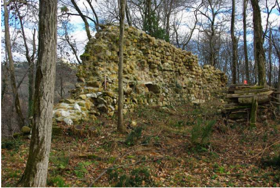
Elévation nord-est - Face interne - On remarquera le décroché marqué dans le parement correspondant peu ou prou au niveau de percement des meurtrières ménagées dans l'épaisseur de la maçonnerie - Vue de l'ouest vers l'est
