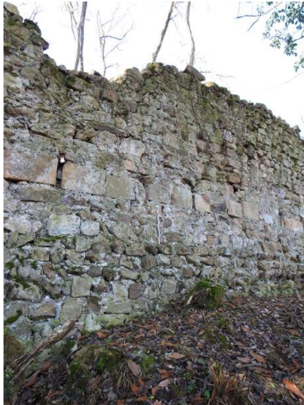
Elévation nord-est (partie) - Face externe - Vue du nord-est vers le sud-ouest
