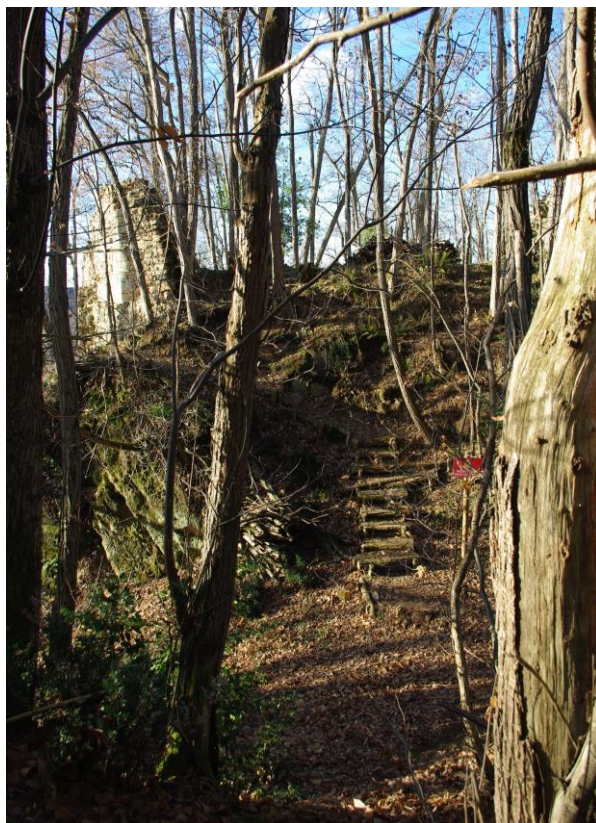
Le castella de Labarre - Le fossé sud et, sur la plateforme sommitale, les vestiges des élévations méridionale et orientale, vus depuis le sud-est.
